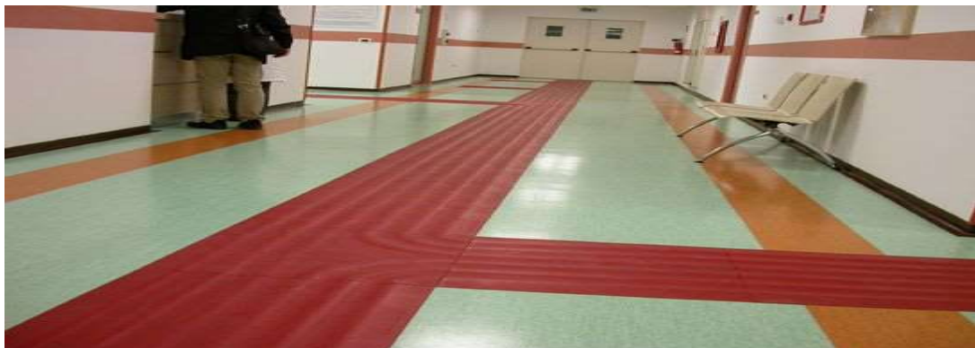
Afb.: Geleide-stroken voor visueel gehandicapten ; Soms worden slechts een paar van de vele in de matrix onzichtbare latente handelingslijnen opeens zichtbaar.
